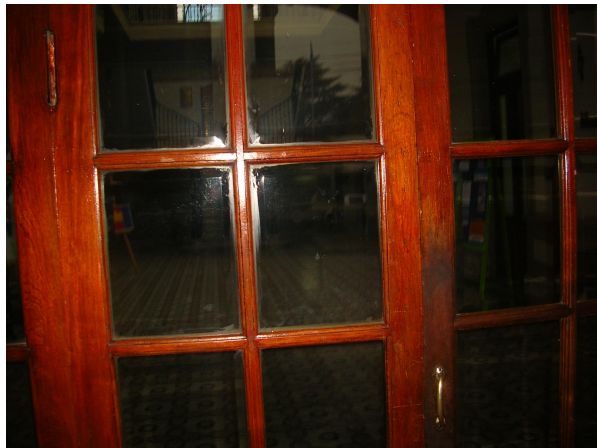
Detalle de la puerta de acceso al hall central.
