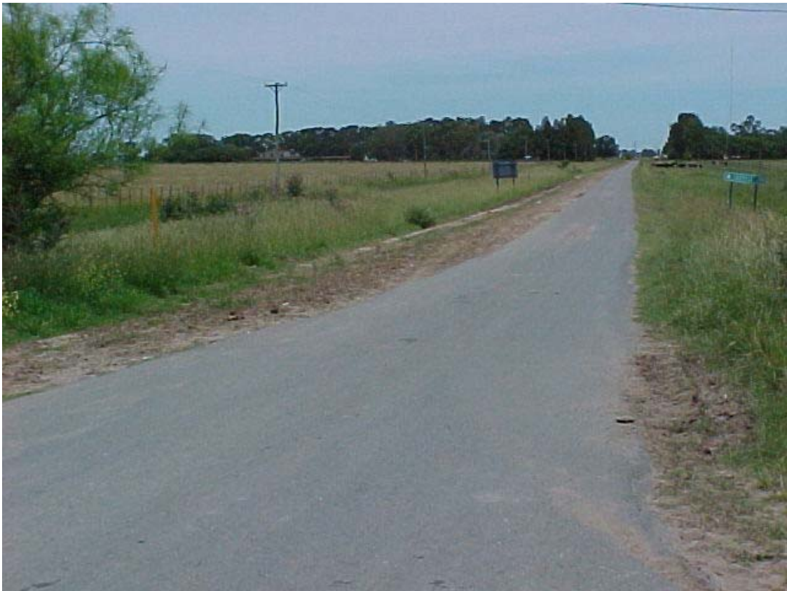
PAVIMENTOS ASFÁLTICOS DE MEDIA CALZADA
